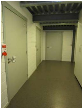
Deze deuren zijn zeer breed. Dit is noodzakelijk voor elektrische rolstoelen en hulpmiddeengebruik. Zeker als de deuren vanuit de gang niet recht op recht bereikbaar zijn.
