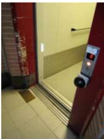
Beschadiging van de lift door een te smalle toegang. Aangepaste oproepknop aan de buitenzijde van de lift. Dominiek Savio, © Enter vzw
