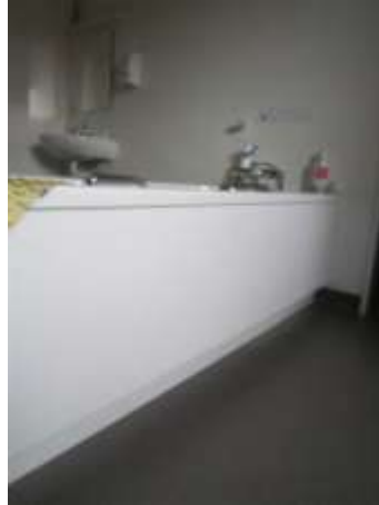
Vrijstaand bad op normale hoogte, met ingewerkte handgrepen en onderstaanbaar uitgevoerd. Maria Ter Engelen, © Enter vzw
