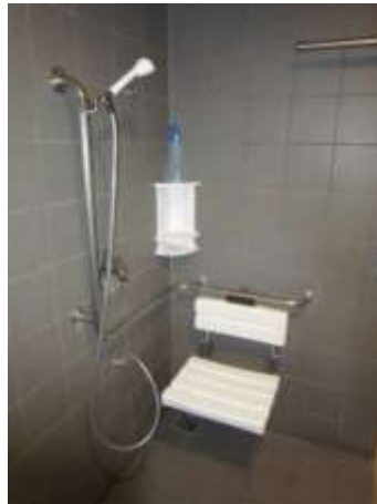
Wegneembare douchezit en hoekwandbeugel die ook als gleistang gebruikt wordt. Mané, © Enter vzw
