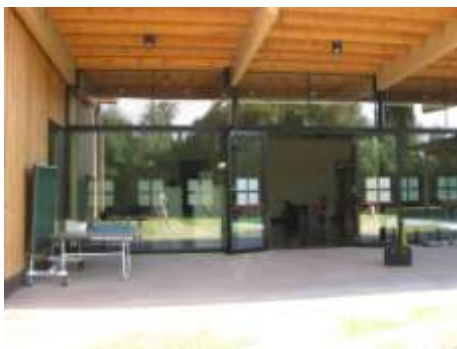
Overdekt terras, rechtstreeks aansluitend op de binnenruimte.
