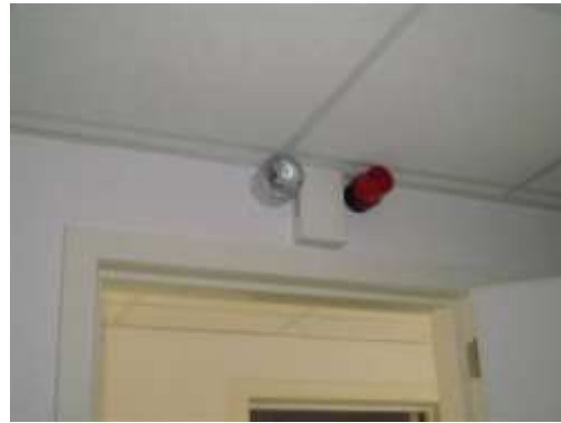
Een lichtflits die auditieve geluiden omzet in een visueel signaal zoals een bel, een alarm, een telefoonoproep ... Kids, © Enter vzw
