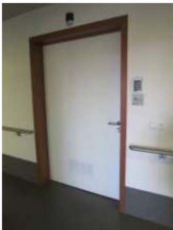
Afgebogen leuning bij de onderbreking aan een deur.
