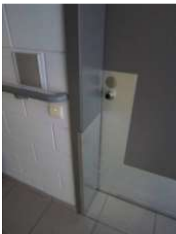
Deuren die gasten niet zelf mogen bedienen, enkel toegang onder begeleiding, met een kaartstelsysteem als slot en een knop als deurkruk. Mané vzw, © Enter vzw
