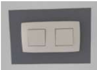
Contrasterende rand rond een verlichtingsschakelaar- naambord met braille - tactiele kaart met brailleaanduiding.
