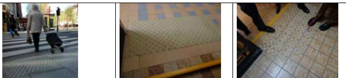
Verskillende uitvoeringen van dezelfde principes kan zeker. Bijvoorbeeld het aanbrengen van noppen in verschillende materialen: inox, tegels, verlijmde kunststof.
