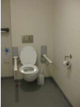
Een scheefgetrokken toiletbril. St. Gerardus, © Toegankelijkheidsbureau vzw
