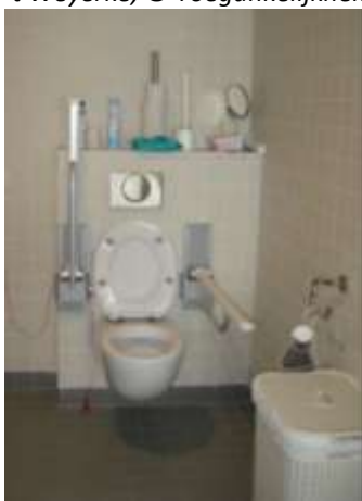
Hangtoilet met in hoogte verstelbare en opklapbare beugels
