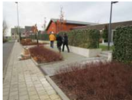
Een combinatie helling en trap geïntegreerd in de omgevingsaanleg: kleine helling naar de trap, het pad loopt in helling verder rond de haag naar de toegangsdeur.
