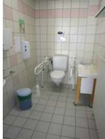
Toilet met opklapbare beugels met extra steunpoot als beveiliging tegen afbreken door neerploffen. Naast de toiletpot staat ook een klein werkblad voor het plaatsen van verzorgingspullen. St. Lodewijk, © Enter vzw
