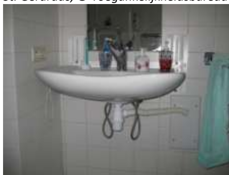
Wastafel gemonteerd op een in hoogte verstelbaar systeem en uitgevoerd met een flexibele afvoer.
