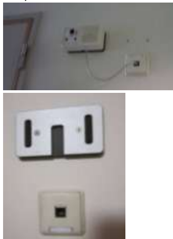
Elk bed is uitgerust met een trilsysteem dat deze aangesloten is op het brandalarm. Kids, © Enter vzw
