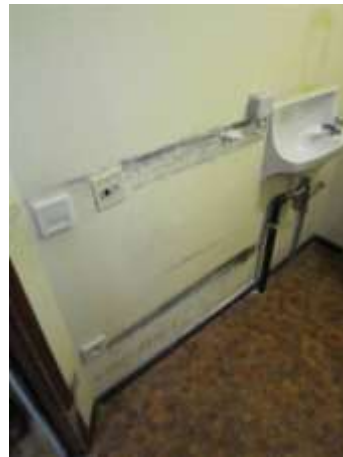
Wandbeschadiging door voetsteunen en joystick van rolstoel. Eigen thuis, © Enter vzw
