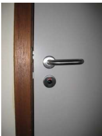
Goed omgrijpbare L-vormige deurkruk. Stijn vzw, © Enter vzw
