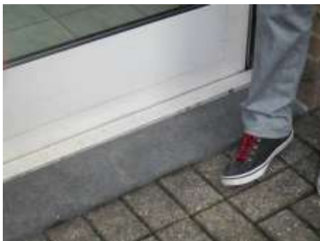
Het kleinste niveauverschil bij een overgang tussen binnen buiten zorgt voor een drempel (rolstoelgebruik).
