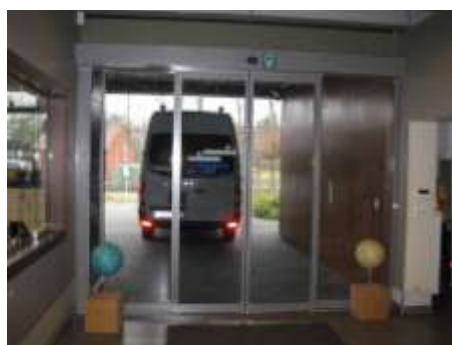
Drempelloze overgang binnen en buiten. Overdekte toegang houdt regen buiten. Stijn vzw, © Enter vzw
