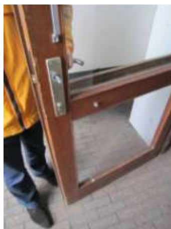
De klink aan de binnenzijde van de deur wordt verwijderd als beveiliging. Maria ter Engelen, © Enter vzw
