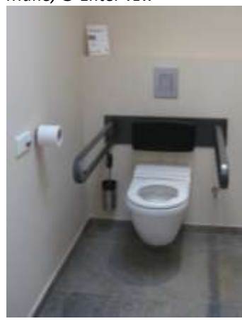
Verlengd toilet met rugsteun en opklapbare beugels UD Woonlabo, © Toegankelijkheidsbureau vzw
