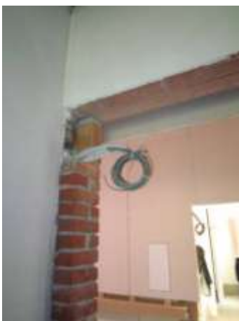
Aansluiting voor deurautomatisatie in ruwbouwfase.
