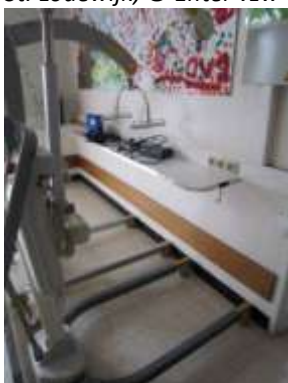
Laadpunt met meerdere stopcontacten per plaats.
