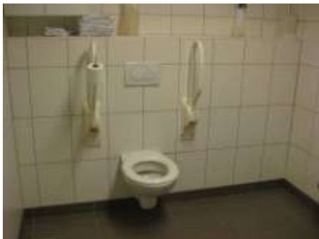
Aangepast toilet met 2 transferzijden en 2 opklapbare beugels, voorzetwand over de volledige breedte van de ruimte.
