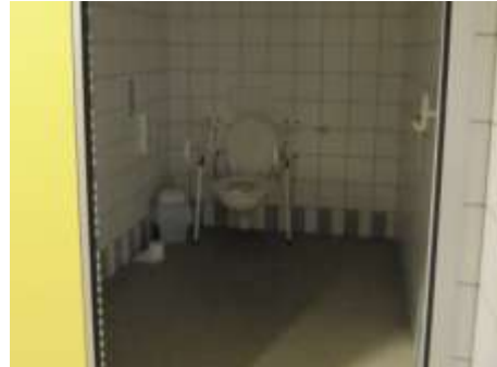
Aangepast toilet met 1 transferzijde. St. Gregorius, © Enter vzw
