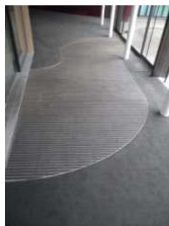
De geleiding tussen de deuren is opgenomen in de vloerafwerking om het circulatiepatroon te ondersteunen.
