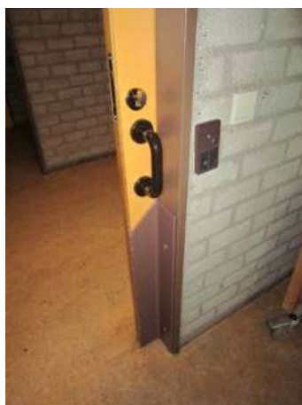
Bescherming van de deur tegen stuk rijden: metalen hoekbeschermer voor het loshangende deel.
