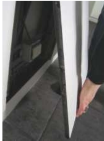
Voetbel, geplaatst ter hoogte van het toilet: Het vlak in de muur kan aangereden worden met de voetsteunen van de rolstoel. Achter de plaat zit een tuimelschakelaar verwerkt.
