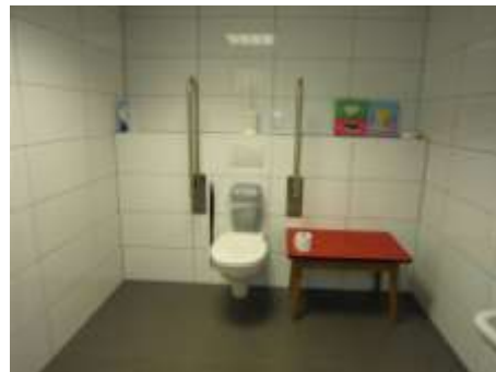
Aangepast toilet met 2 transferzijden en 2 opklapbare beugels, voorzetwand over de volledige breedte van de ruimte.
