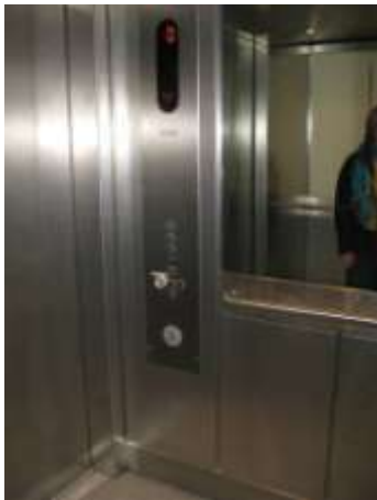
Verticaal bedieningspaneel op goede gebruikshoogte. St. Lodewijk , © Enter vzw
