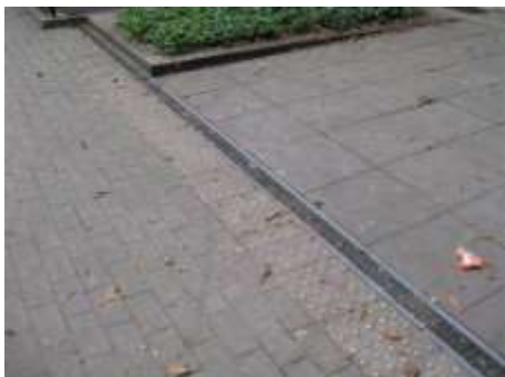
Rooster langs en dwars op de circulatierichting. Langs het rooster is routegeleiding aangelegd naar de toegangsdeur. KI Woluwe, ©Enter vzw
