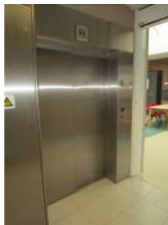
Lift met brede toegang. Omdat ze niet zo goed zichtbaar (herkenbaar) is, werd een extra pictogram bovenaan toegevoegd. Maria ter Engelen, © Enter vzw
