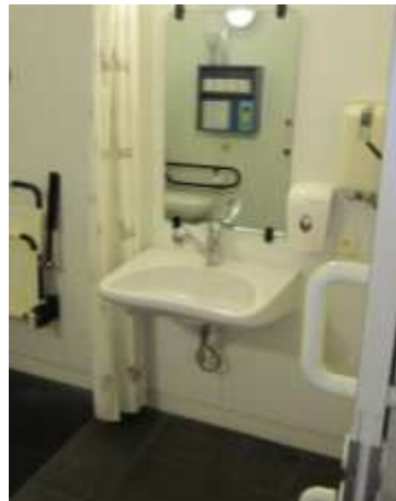
Wastafel met kraan met hogere uitloop (en met sproeikop) in een badkamer. Eigen Thuis; © Enter vzw
