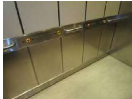
Aangepaste knoppen voor personen met een beperkte handfunctie. Dominiek Savio, Molenreke © Enter vzw
