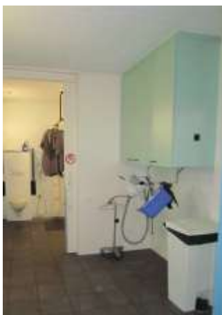
Bergruimte op hoogte aan een badkamer, zo blijft de nodige manoeuvreerruimte vrij op vloerniveau voor het draaien met rolstoelen of het gebruik van tilhulpmiddelen. Eigen thuis vzw, ©Enter vzw
