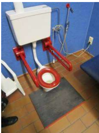
Steunbeugels en voldoende stabiele voetsteun op kleuterhoogte.
