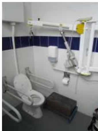
Tilhulpsysteem (wandbevestiging) in een toilet voor jongere kinderen, met voetsteun op zithoogte.
