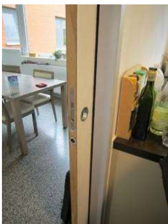
Schuifdeur met een ingewerkte greep die zeer moeilijk te gebruiken is! Maria ter Engelen, © Enter vzw
