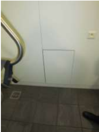
Voetbel, geplaatst ter hoogte van het toilet: Het vlak in de muur kan aangereden worden met de voetsteunen van de rolstoel. Achter de plaat zit een tuimelschakelaar verwerkt.
