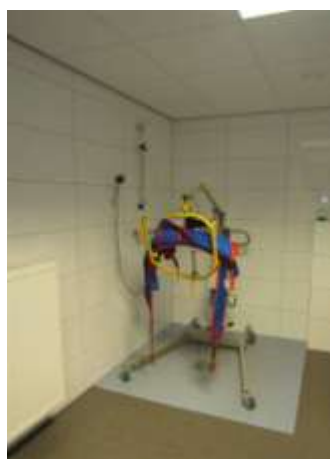
Vlakke douche met verrijdbare tillift. Naast de doucheglijstang is een extra douchekophouder op bereikbare hoogte voor zorgverleners. Stijn vzw, © Enter vzw
