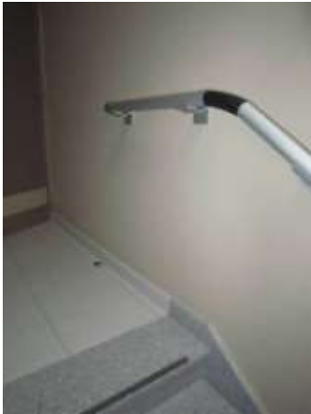
Doorlopende leuning na het einde van de trap. Maria ter engelen, © Enter vzw
