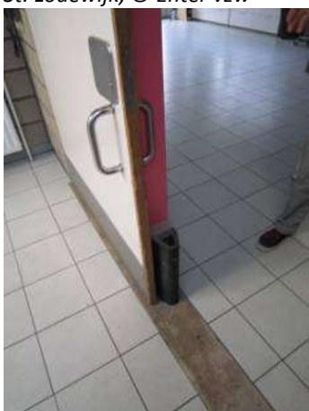
Bescherming van de deur tegen stuk rijden: kunststof hoekbeschermer voor het loshangende deel.
