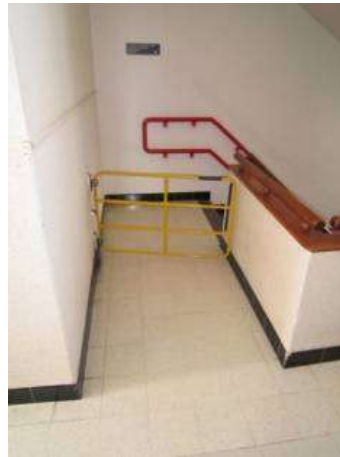
Trapbeveiliging voor roelstoelgebruikers. De leuning loopt 40 cm door voorbij de trede en is afgerond van vorm. St. Lodewijk , © Enter vzw
