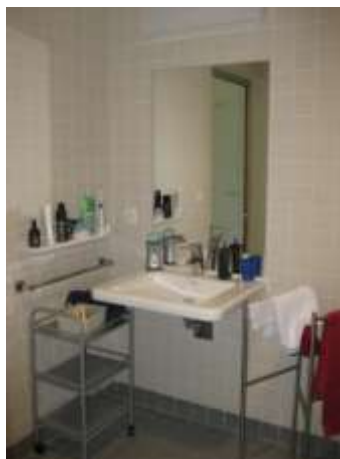
Onderrijdbare wastafel met tablet aan linkerzijde waardoor benodigdheden binnen handbereik staan
