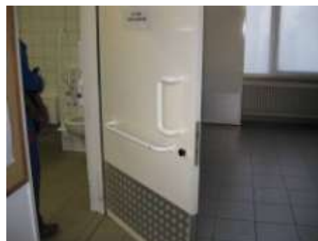
Deur met horizontale beugel en verticale handgreep. Dominiek Savio, © Enter vzw
