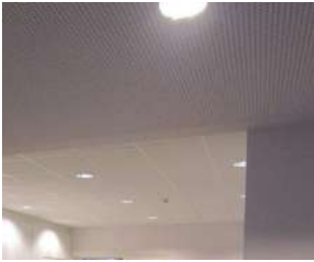
De plafondafwerking in geperforeerde platen voor de akoestiek. Egale verlichting over de volledige ruimte.
