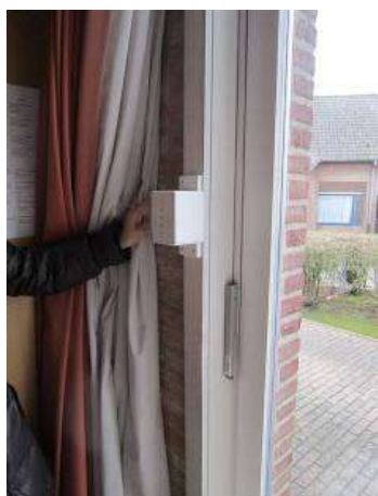
Voorbeeld van beveiliging van rolluikdrukknop in een houten kastje.
