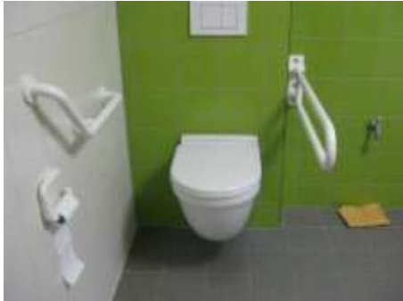
Aangepast toilet met 1 transferzijde. De gie, © enter vzw
