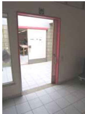
Schuifdeur met brede dagmaat voor dagelijks gebruik van elektrische rolstoelen.
