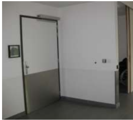
Buitendraaiende inkomdeur met automatische deuropener bediend d.m.v. een badgelezer. De deur is ook uitgerust met een bel. St. Gerardus, © Toegankelijkheidsbureau vzw
