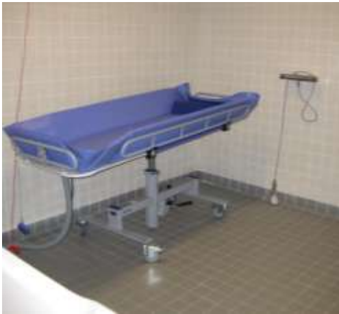
Verrijdbare douchebrancard, ook bruikbaar als verzorgingstafel. De kraan staat op een goede bereikbare plaats (douchehouder is niet aanwezig).
